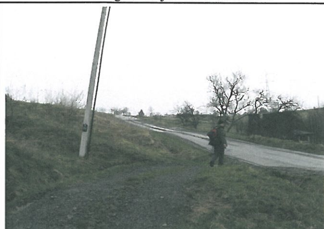
Fot. 4. Przechylony słup linii telefonicznej przy uszkodzonym fragmencie asfaltowej drogi gminnej.
