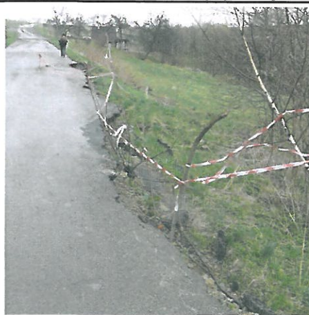
Fot. 6. Uszkodzony odcinek (ok. 100 m) drogi gminnej asfaltowej.
